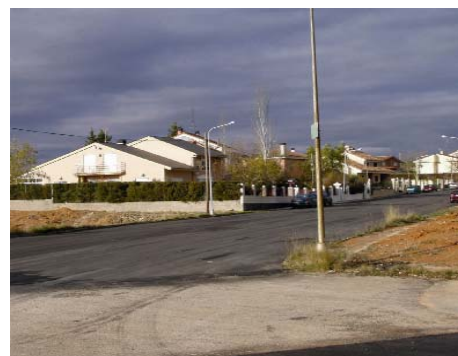
Asfaltado del Barrio de San José
