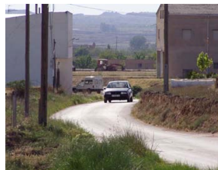
Asfaltado del camino de la Torrecilla
